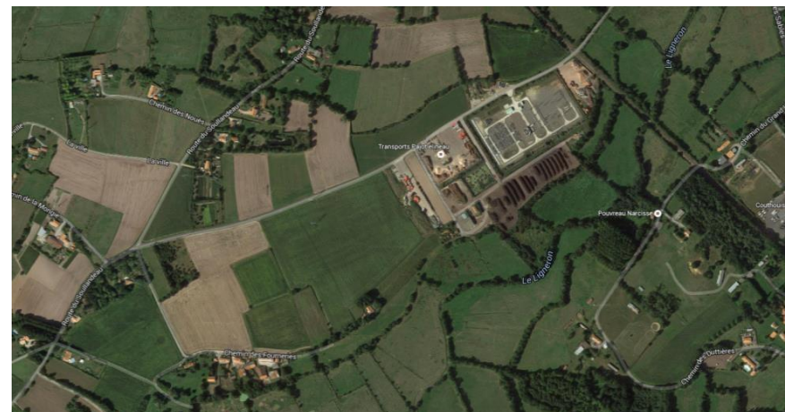
Figure 44 : vue aérienne du poste RTE
