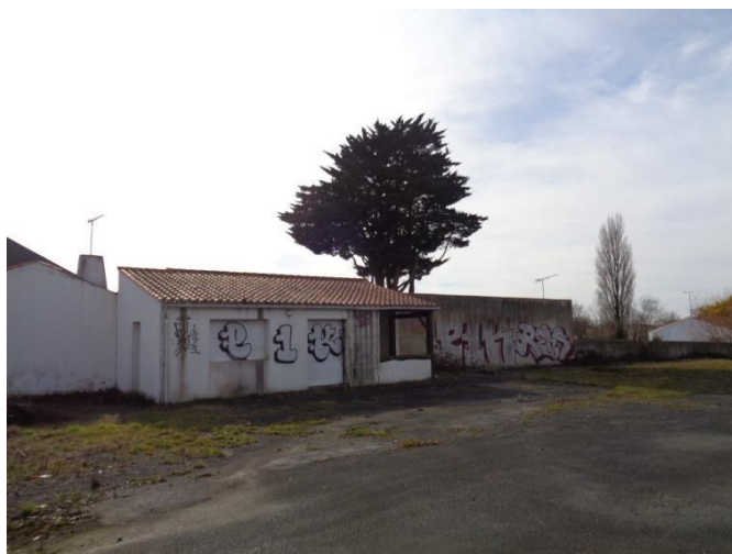
Figure 4 : Ruines existantes de l'ancienne entreprise
