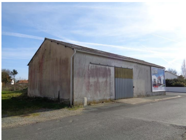
Figure 10 : Bâtiment à intégrer au périmètre de l'OAP
